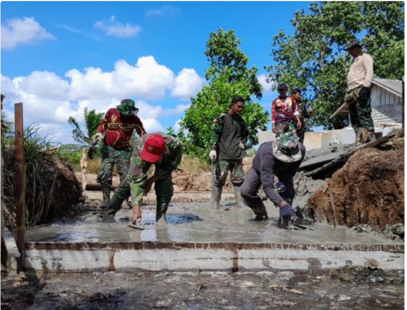
Memasuki Minggu Ke Dua, Satgas TMMD Mulai Cor Dasar Box Culvert
