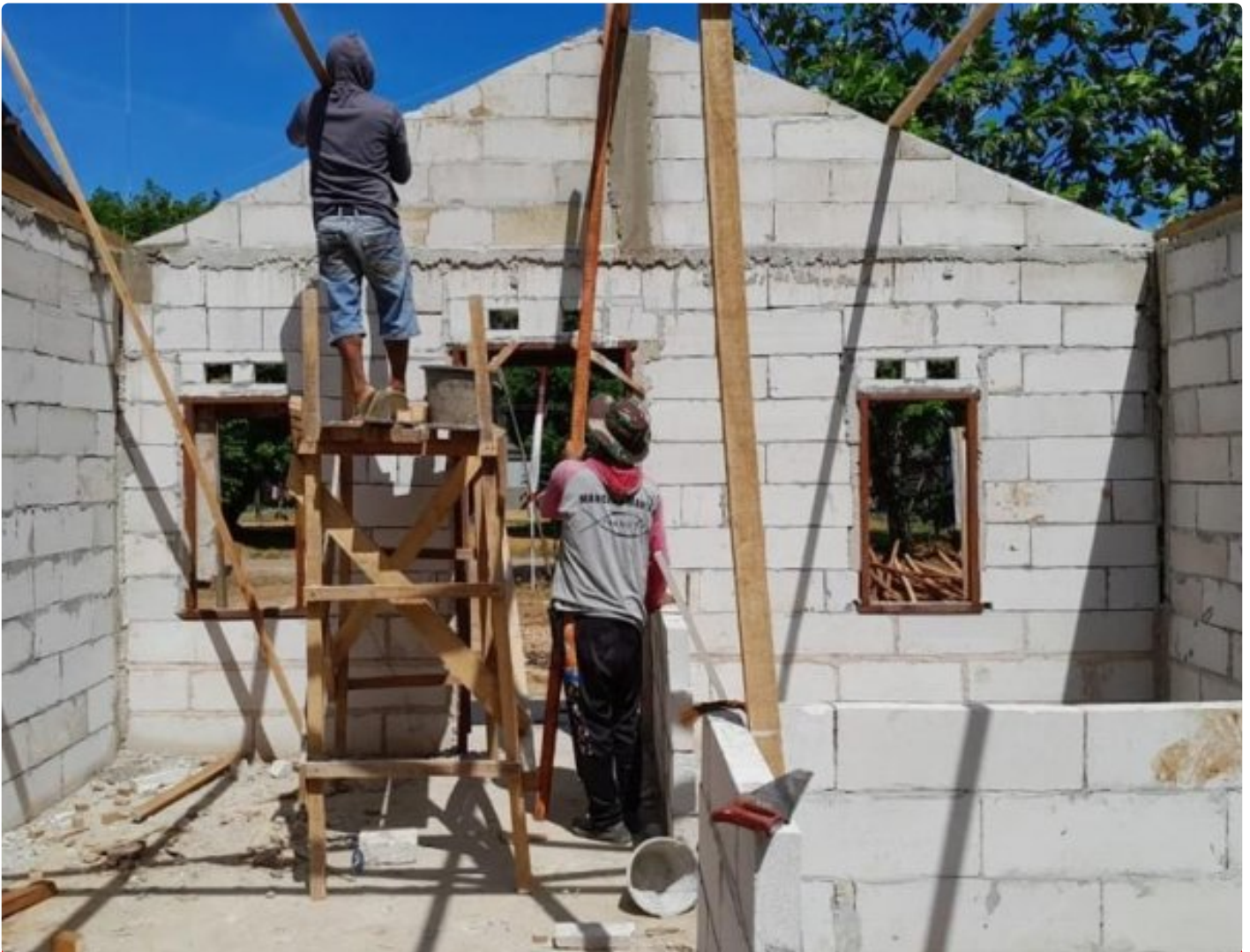
Rasa Haru Mbah Sandi Melihat Dinding Rumahnya Sudah Berdiri
